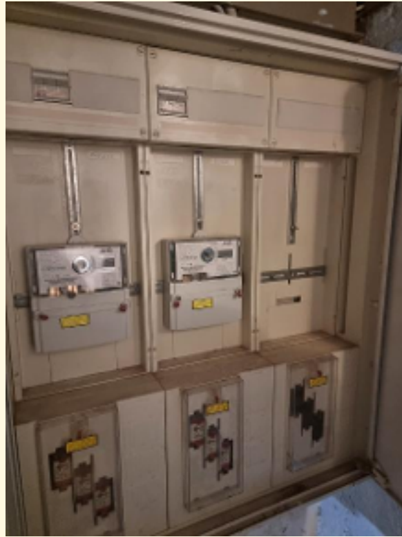
31 - Stromzähler für EG und OG
