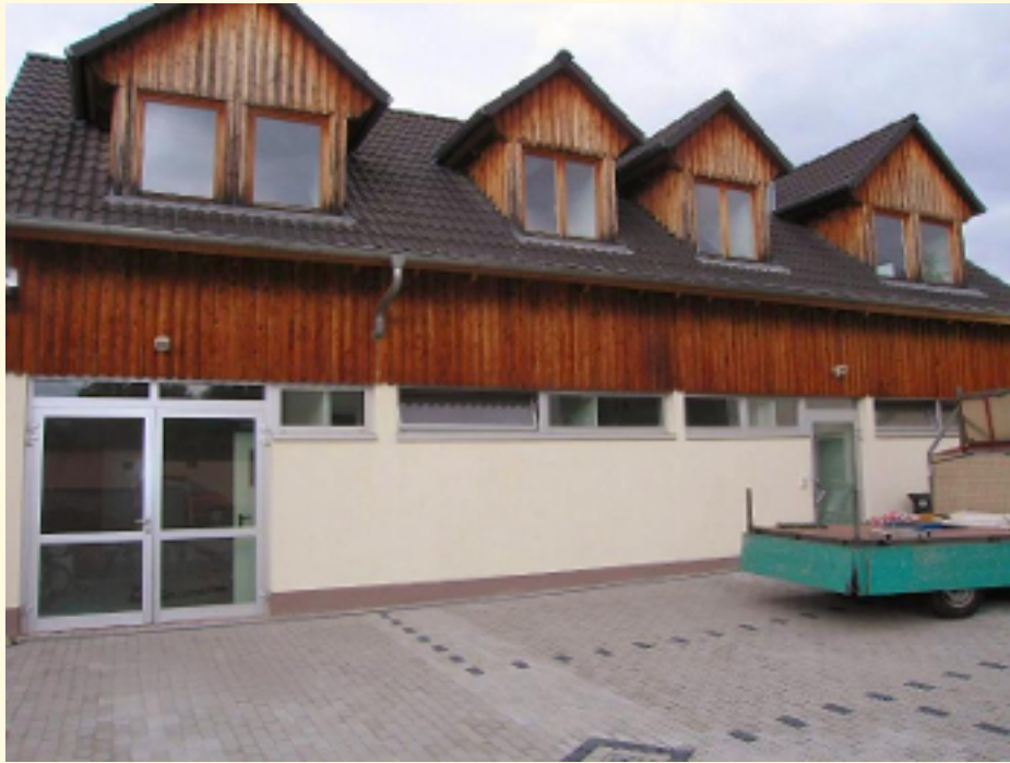
Bürotrakt Lager Außenbereich
